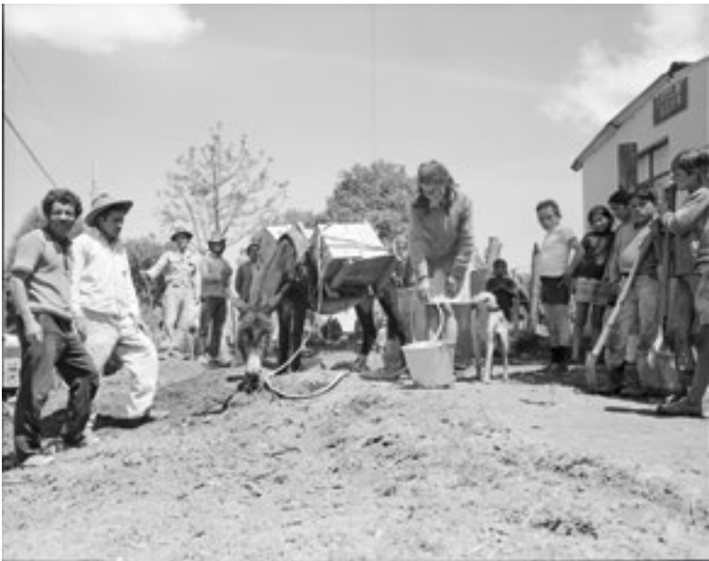
SAÚL ORDUZ Acueducto comunal de Suba Fotografía 1972
