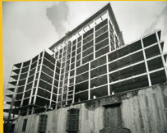
PAUL BEER · Obra Edificio Policía Nacional · Fotografía · Sin fecha
