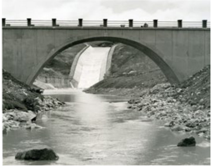
PAUL BEER · Puente sobre el canal de desagüe · Fotografía · 1951
