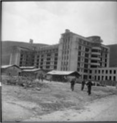
DANIEL RODRÍGUEZ [Construcción Hospital San Carlos] Fotografía ca. 1945
