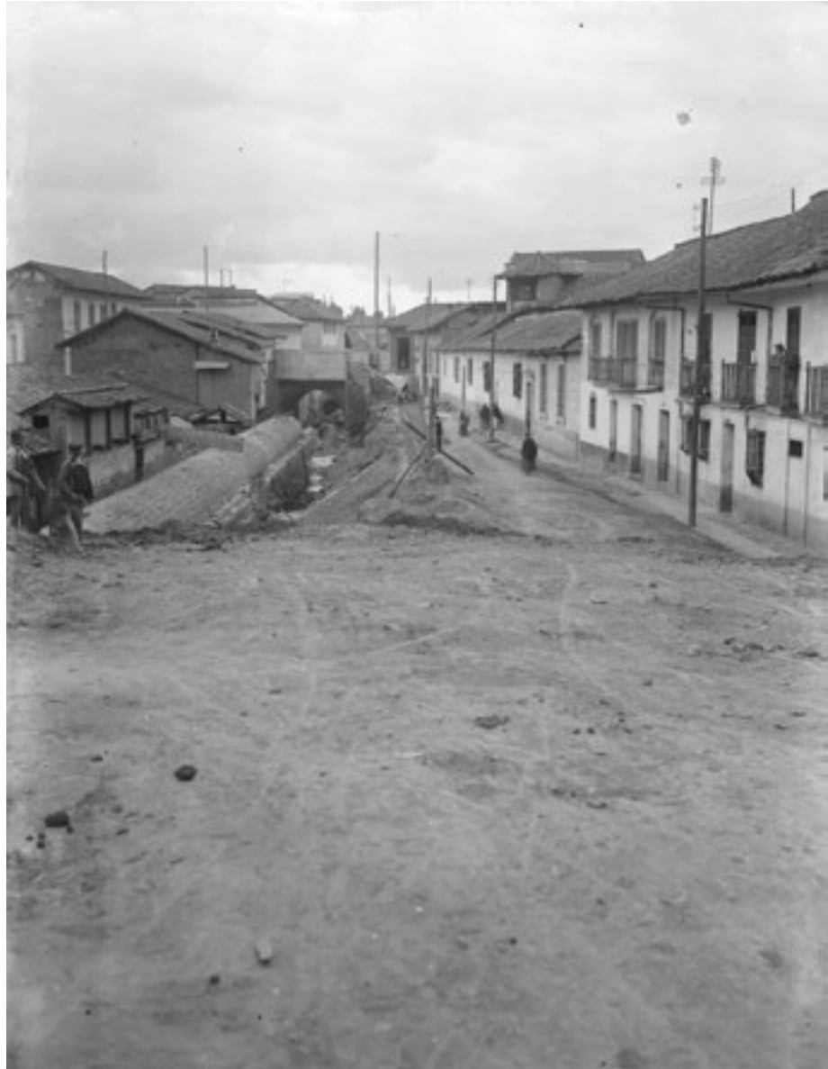
AUTOR POR IDENTIFICAR · [Canalización del río San Francisco] · Fotografía · ca. 1915
