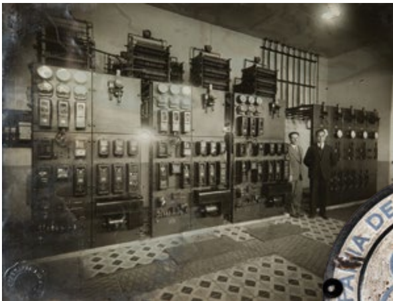
CÁMARA DE COMERCIO DE BOGOTÁ · Tablero convertidor en una de las instalaciones de la Empresa de Energía de Bogotá ubicada en la calle 26 · Fotografía · 1978
