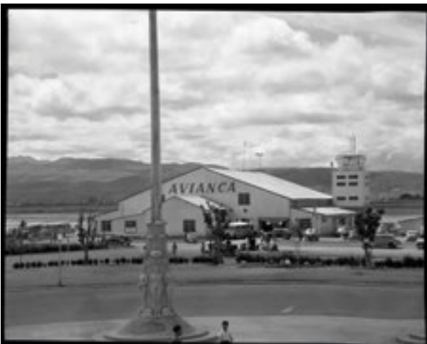
SAÚL ORDUZ · Edificio Despacho Aeropuerto de Techo · Fotografía · 1950
