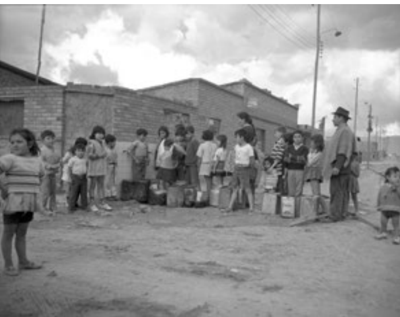
SAÚL ORDUZ Acueducto comunal de Suba Fotografía 1972
